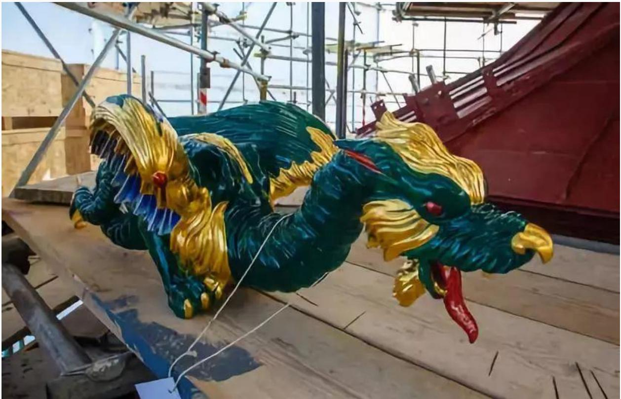
现在，由于历史悠久的皇家宫殿(HRP)和 3D Systems 之间的合作，72 个基于原始装饰的大型龙已经 3D 打印，并被安装在历史悠久的联合国教科文组织世界遗产建筑上。3D 打印龙的安装不仅标志着 HRP 最近在 Kew 的大宝塔恢复工作的完成，也标志着教科文组织项目中增材制造的最广泛使用。
